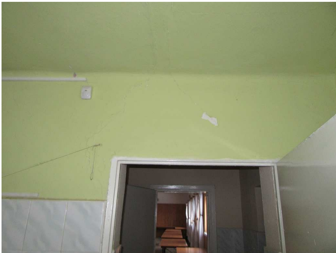
Zarysowania odchodzące od belki stropowej, powstałe w wyniku zbyt dużego ugięcia nadproża. Do naprawy.
